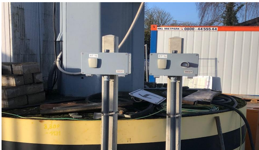
Abbildung 4: Ein- und Ausschalttaster Höhe Gleistor (Gleis 1652)
